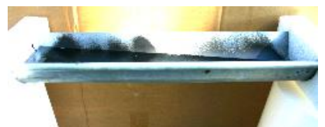
Après séchage : Les fuites sont obturées
